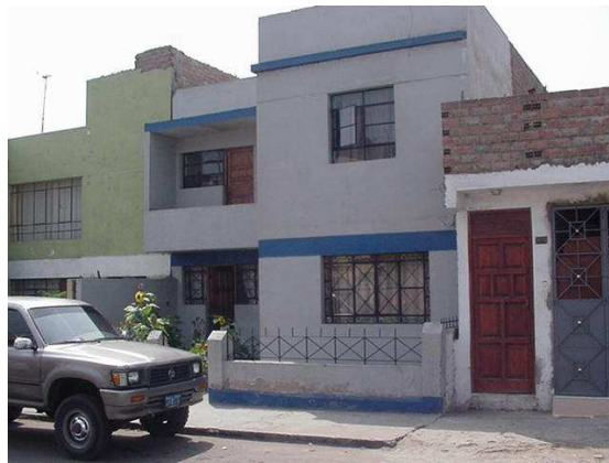
Foto 1. Escena del Hecho : Vivienda de 3 pisos donde se produjo el suceso.
